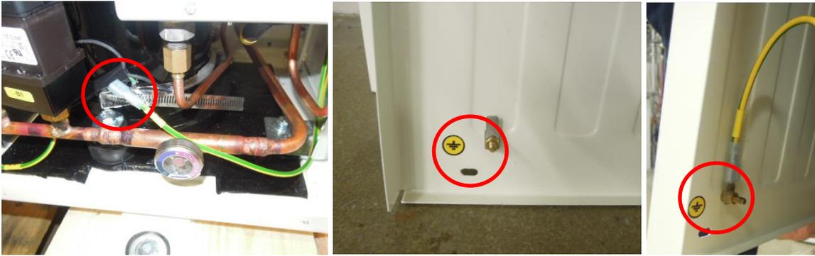
Figure 11 : Détails de la mise à la terre
